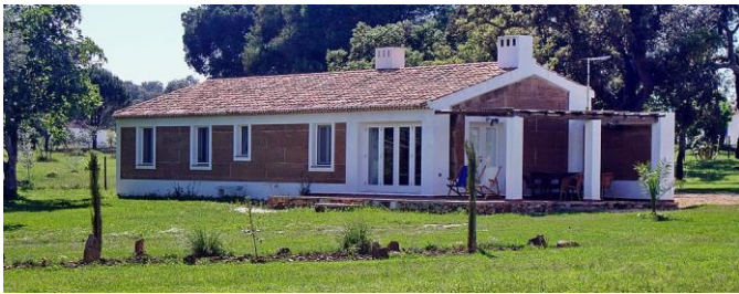
Cottage at Casa Verdemar
